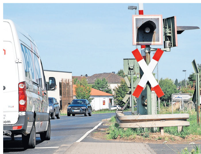
Der Bahnübergang Alsfelder Straße wird mehrfach tageweise gesperrt.
